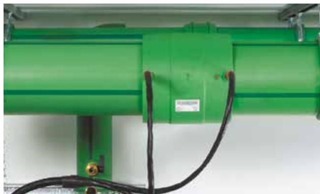
Na svářečce nastavte průměr elektrotvarovky. Spusťte zařízení a kontrolujte proces svařování. Dodržujte dobu chlazení!
