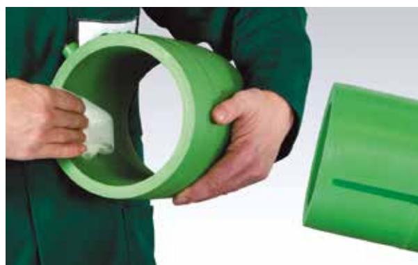
Vyčistěte vnitřek elektrotvarovky. Bezprostředně před svařováním zbavte elektrotvarovku veškeré vlhkosti.
