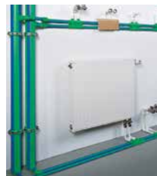
Zapojení systému podlahového vytápění nebo připojení otopných těles může být provedeno pomocí potrubí blue pipe.
