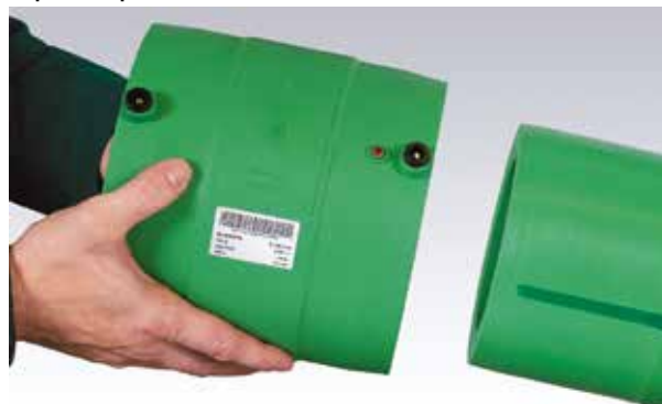
Nasuňte elektrotvarovku na konec trubky.
