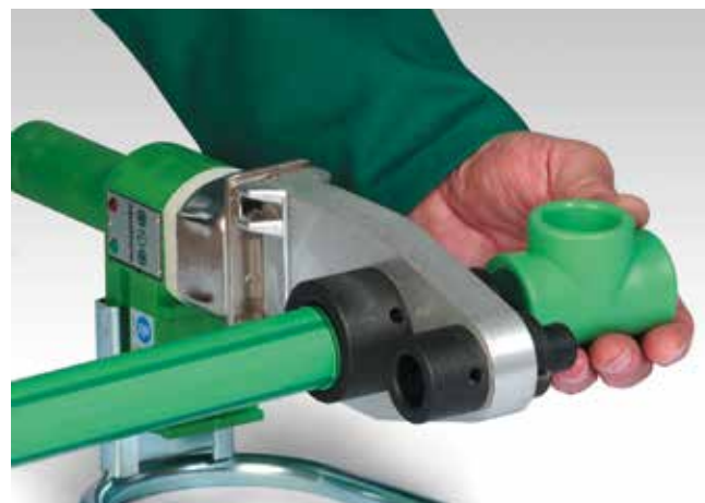
Ohřev trubky a tvarovky
