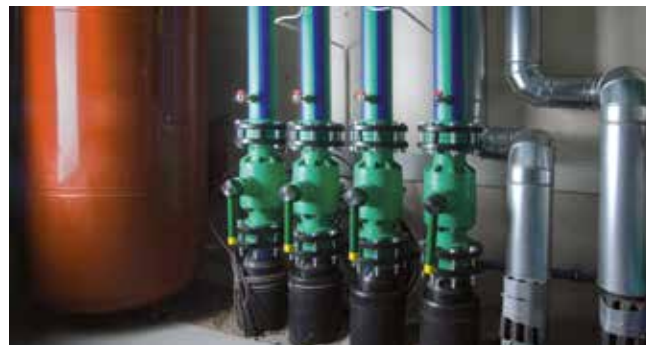
Přírubové spoje umožňují napojení všech komponentů na dálkové vytápění.
