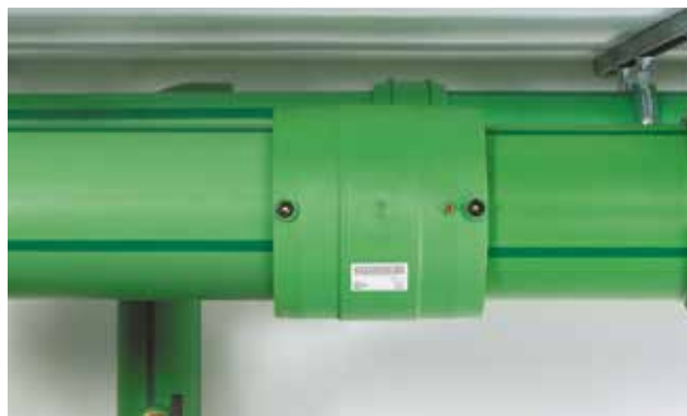
Zatlačte druhou trubku - také ořezanou a vyčištěnou - do elektrotvarovky.
