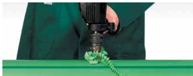
Provrtání stěny potrubí
