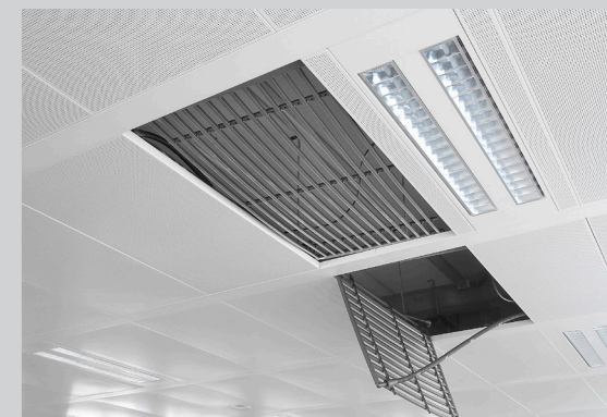
Strop s kovovými kazetami
