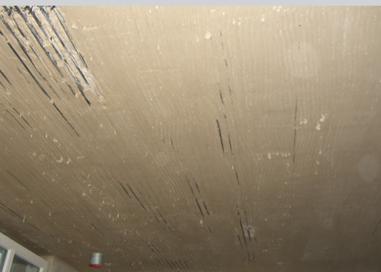
Stropní vytápění a chlazení – omítka
